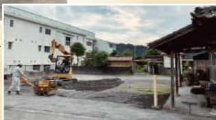
「一乗寺第2駐車場」整地
